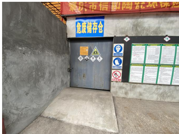
危险废物仓库
